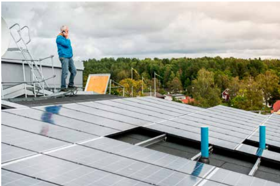
Lars-Göran Karlsson inspekterar solpanelerna på Sjöängens tak.
