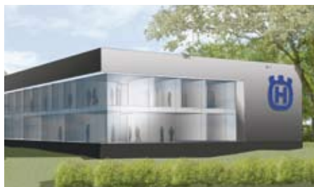
Arbetet med Husqvarnas nya lokaler, vid infarten till Åsbro, pågår för fullt.
