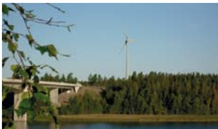
Askersunds bostäder bygger inom kort ännu ett vindkraftverk vid Stora Hammarsundsbron.
