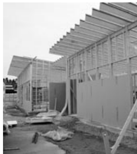
A-huset vid Åsbro skola byggs nu upp igen efter branden förra sommaren.
